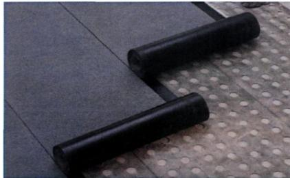
Рис. 26 - Устройство «вентилируемой» кровли с применением перфорированного материала
